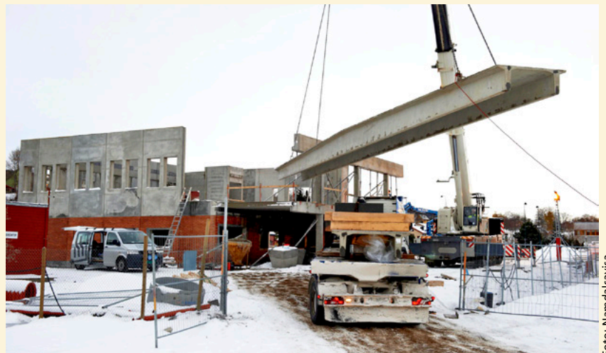
Den nye brannstasjonen som er under bygging vil få fjernvarme.
