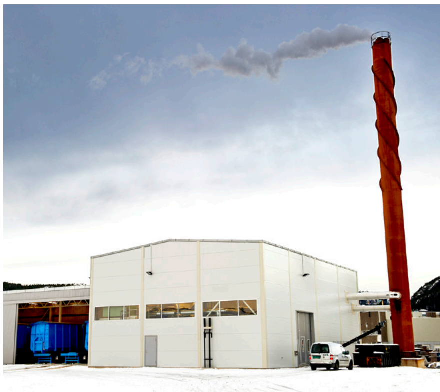
29. november er det åpning av det nye fjernvarmeanlegget.
