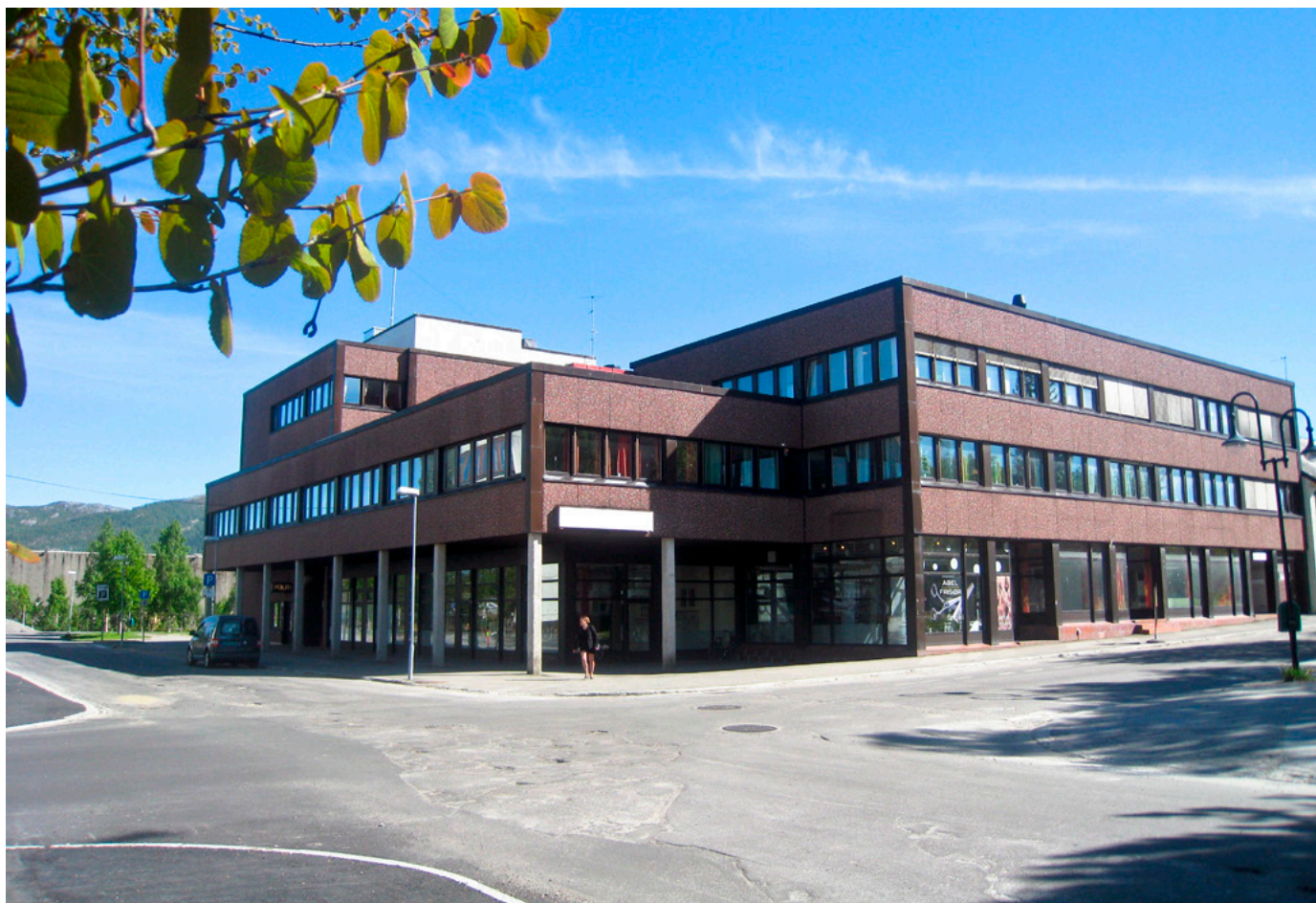
Eierne av Abel Meyers gate 10 vurderer å skifte ut el og olje til fordel for oppvarming med bioenergi.
