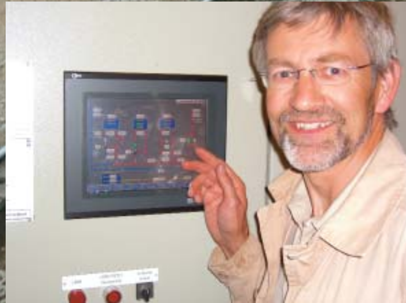
Ut fra varmesentralen går det 120.000 liter varmt vann i timen, sier prosjektutvikler i Bio Varme, Erik Nilssen.
